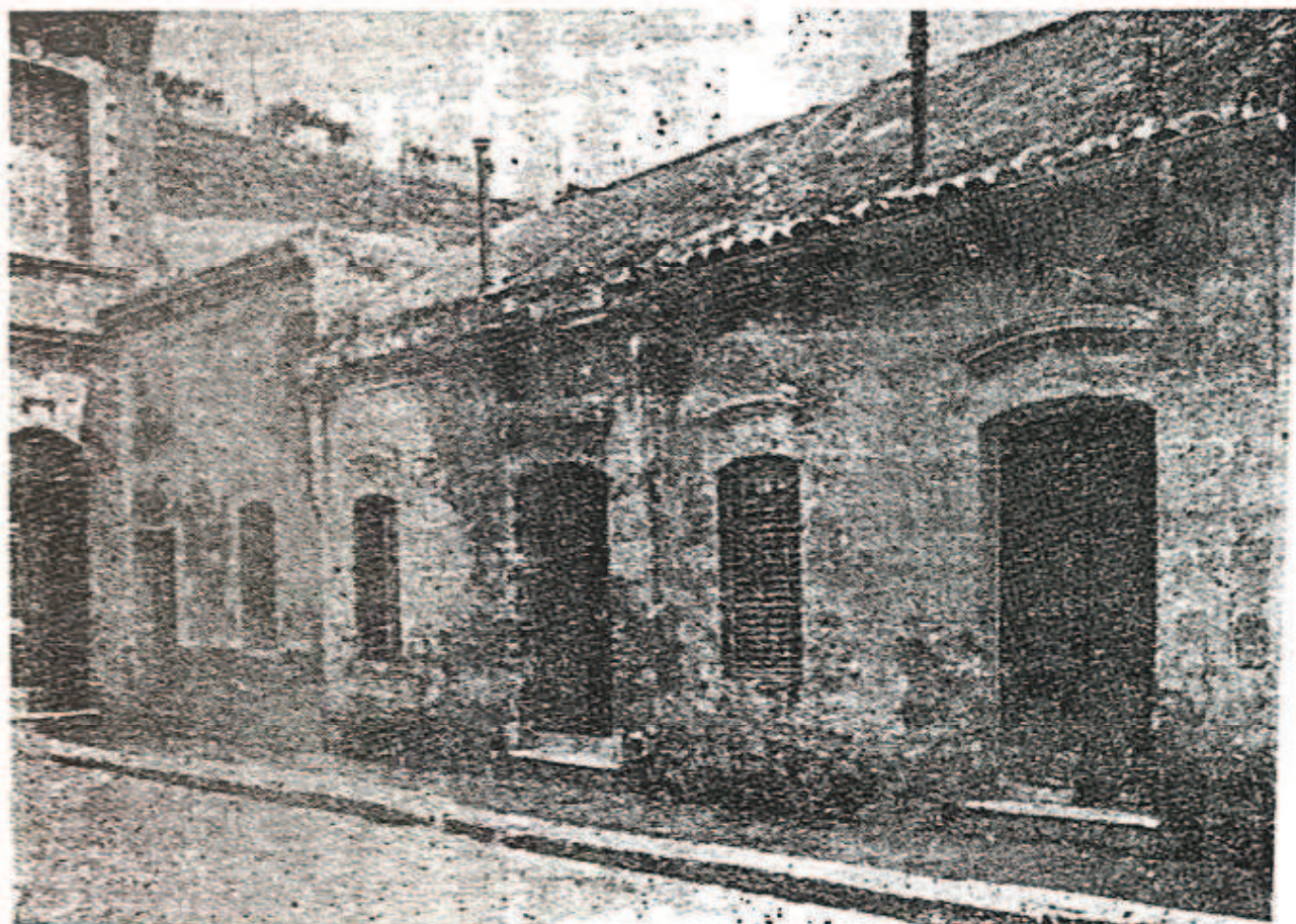
Fig. 31. Antigua residencia convertida en conventillo, en la calle Humberto 19, 439 al 51. (Archivo General de la Nación)
